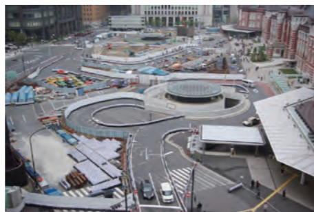
都市の広場（仮称）整備区画
